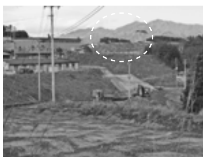
工事中の大槌病院(上)と山田病院(下)
